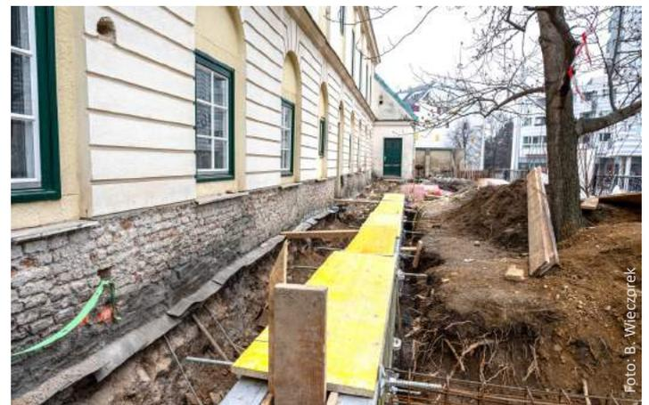
20. Februar: Im Garten entsteht ein barrierefreier Zugang zur Pfarrkanzlei. Im Bild die Schalung der Rampen-Stützwand.
