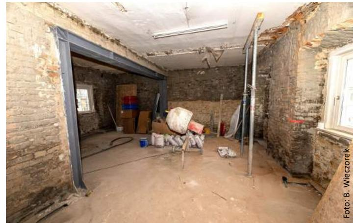
20. Februar: Blick in das neue Pfarrcafé: Die Bodenplatte ist fertig, der Rahmen für die entfernbar Raumteilung ist montiert.
