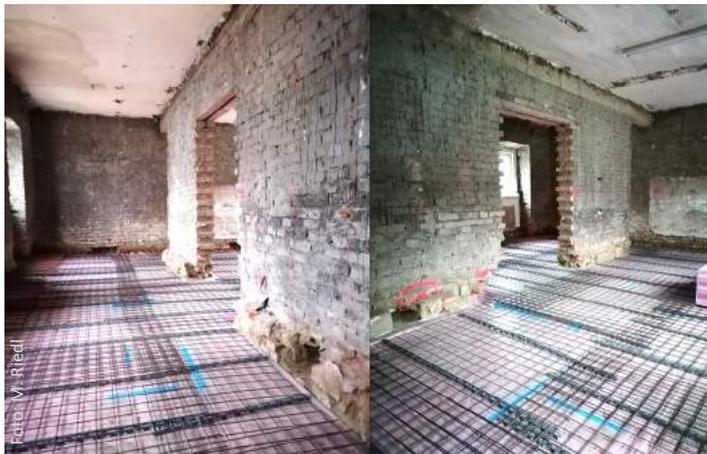
23. Jänner: Vorbereitungen zur Betonierung der Bodenplatte (hier im Bereich des Pfarrcafés) sind abgeschlossen.
