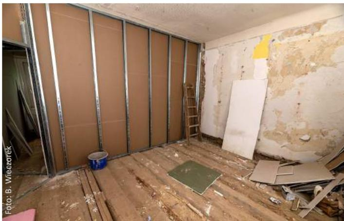
20. Februar: Das Aufstellen der neuen Zwischenwände im Obergeschoss, in dem zwei Wohnungen entstehen, ist am Laufen.
